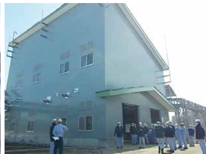
Mg-E球状微粒品増産工事試運転前安全監査 (二本木工場、2021年3月4日)
