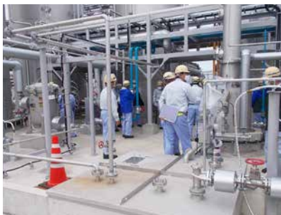
排水インフラ総合対策工事試運転前安全監査 (二本木工場、2020年9月11日)
